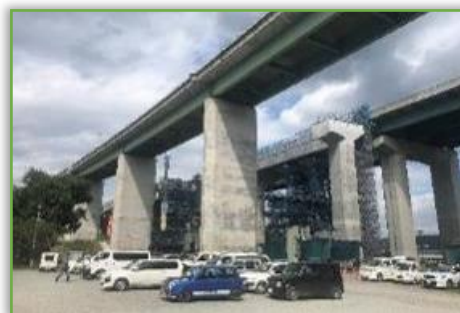
新駒門高架橋(鋼上部工)
