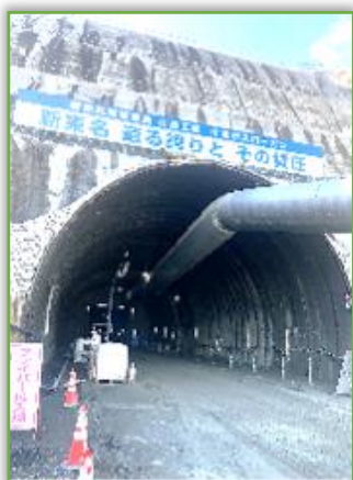
新東名高速道路 谷ヶ山トンネル
