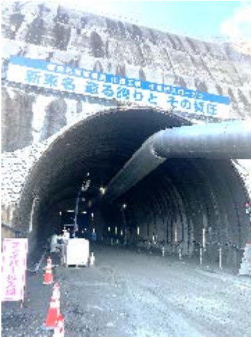
新東名高速道路 谷ヶ山トンネル工事
