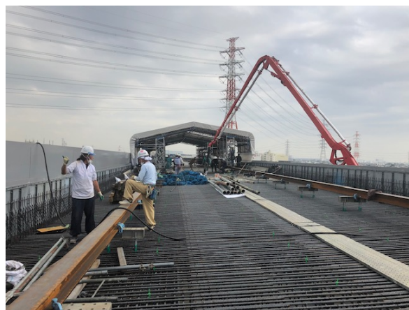
新東名高速道路 歌川橋（鋼上部工）工事
