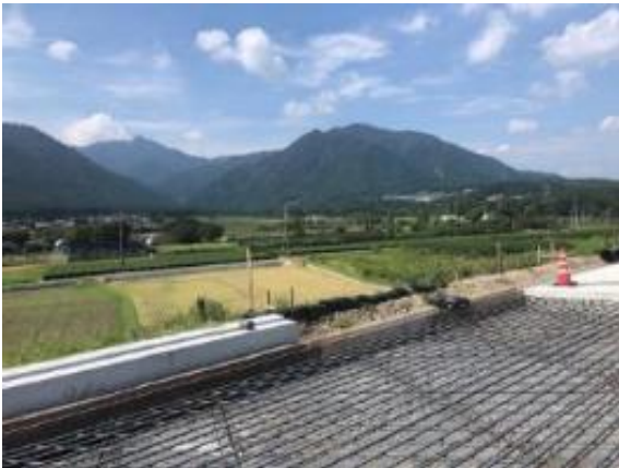
新名神高速鈴鹿舗装工事
