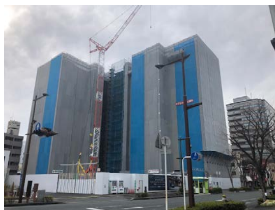
常盤町レジデンスマンション工事
