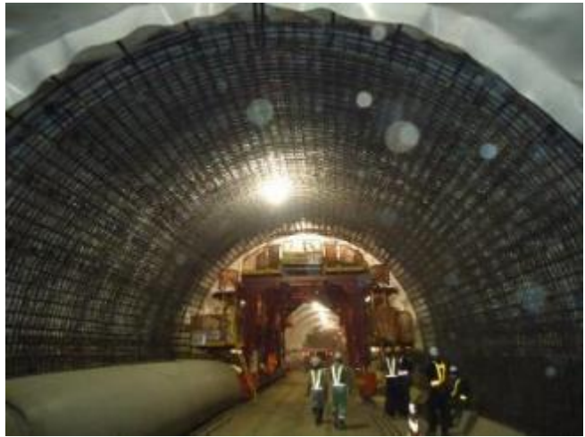
仙台市地下鉄東西線亀岡トンネル
