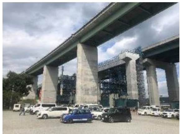
新東名高速道路 新駒門高架橋（鋼上部工）
